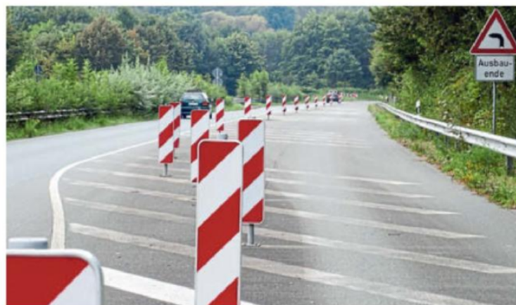
Am Gewerbegebiet Barkhausen endet die ausgebaute B65. Ob die Straße verlängert wird, ist weiterhin unklar. MT-Archivfoto: Manfred Otto
